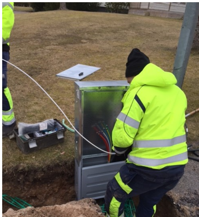
El, tele och fiberdragningar
