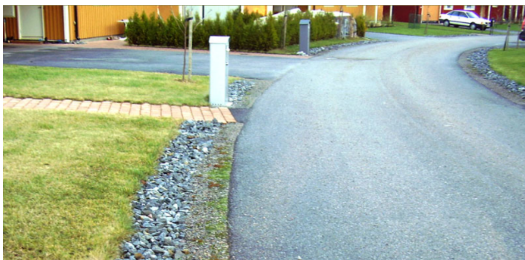
Figur 4: smala makadamdiken på båda sidor av en lokalgata i ett småhusområde (foto: Stockholm vatten och avfall )
