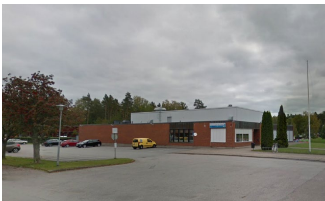
Figur 7 Befintligt badhus som ska rivas.
