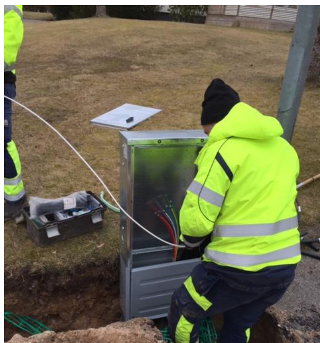
El, tele och fiberdragningar
