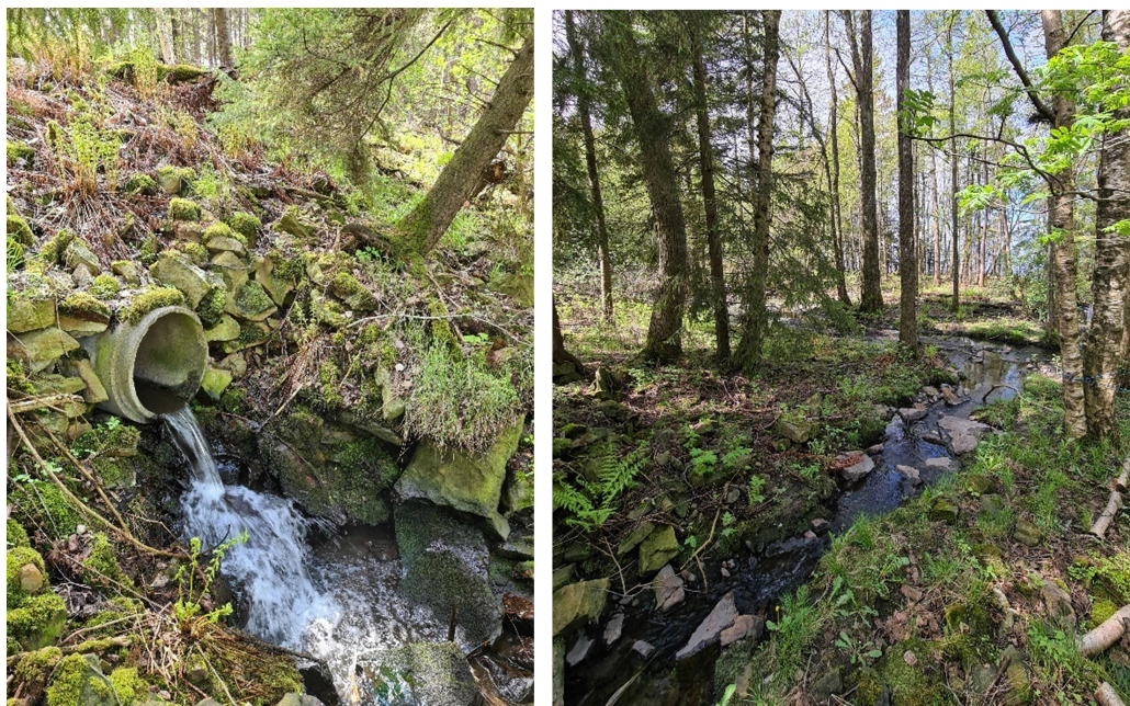
Figur 4 DV1, utloppstrumma (t.v.) och vidare avledning till Vänern (t.h.).
