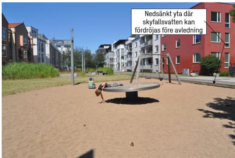
Figur 5-16 Multifunktionell yta där höjsättning av ytor och utflödespunkter genererar fördröjningsvolym för skyfallshändelser.
