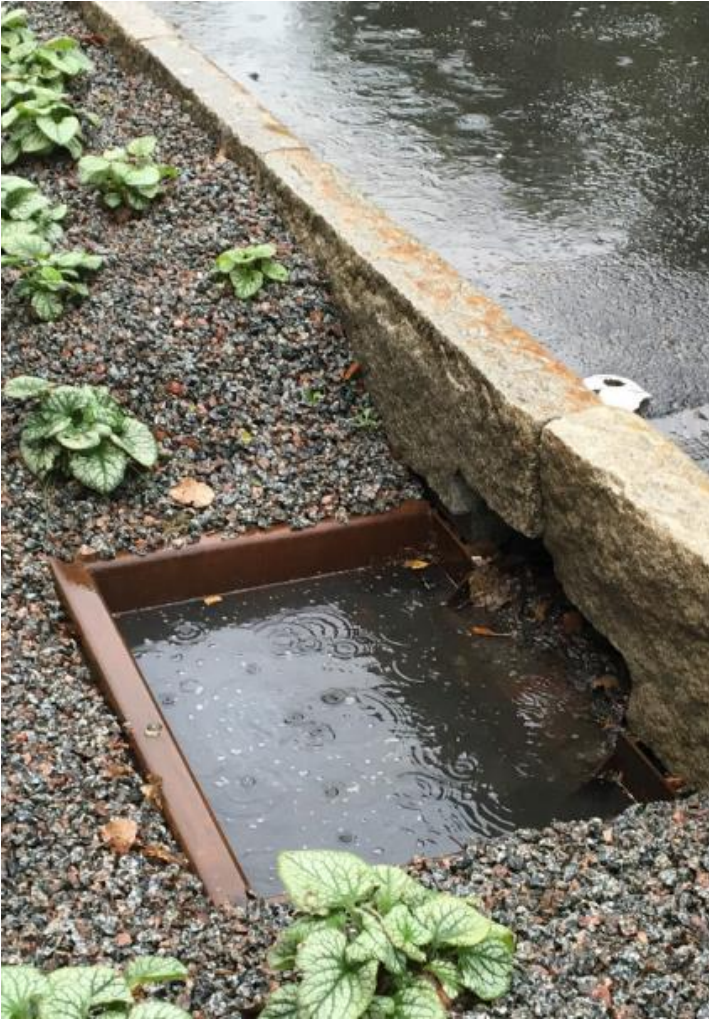
Figur 5-6. Exempel på makadam nära inloppet och sandfångstkar. Bild hämtat från Uppsala kommun (Uppsala kommun, 2025).
