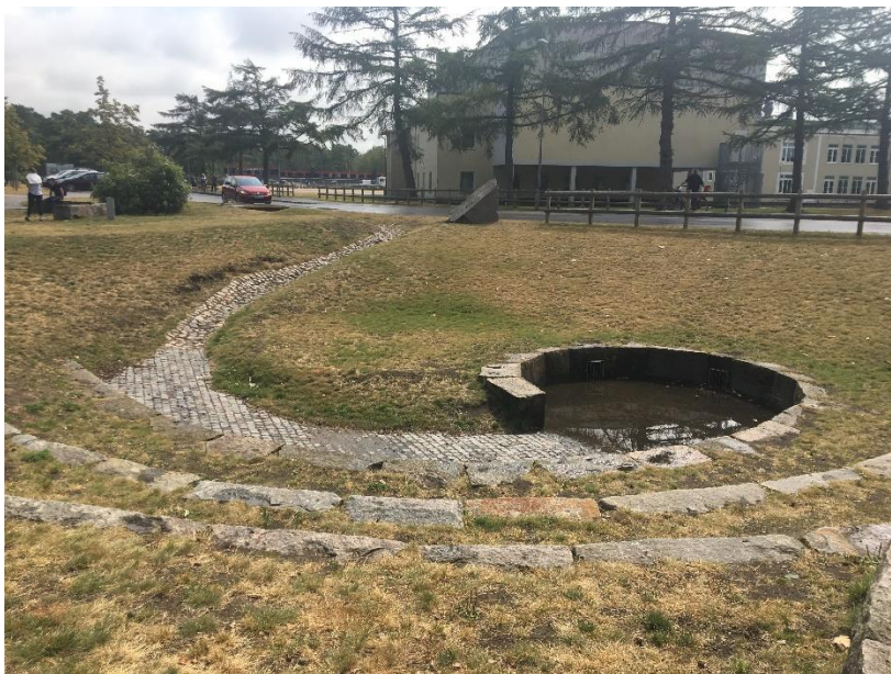
Figur 5-17 Nedsänkt fördröjningsyta för skyfallshändelser invid en lekplats som kan användas som till exempel sittyta vid torrtilfällen.
