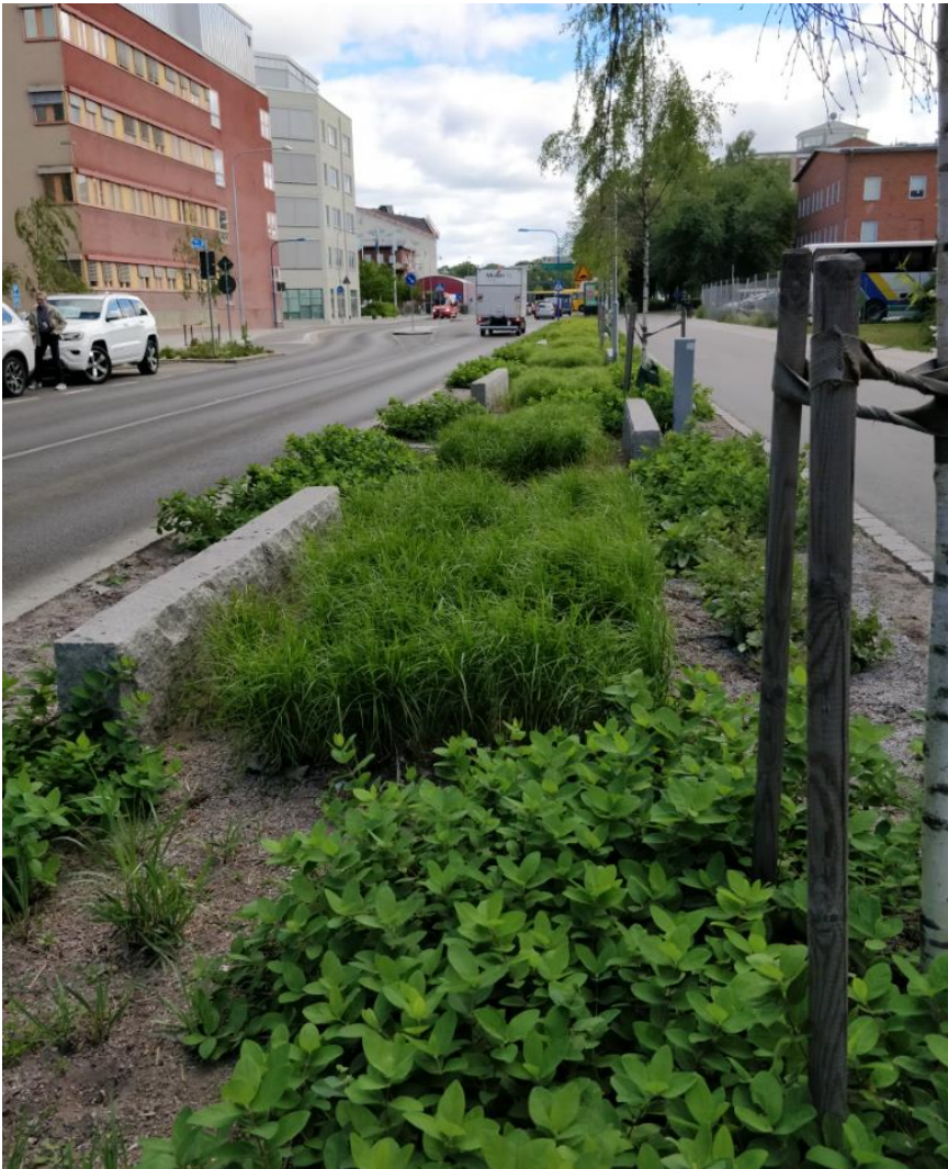
Figur 5-3. Exempel på nedsänkt växtbädd längst med väg.
