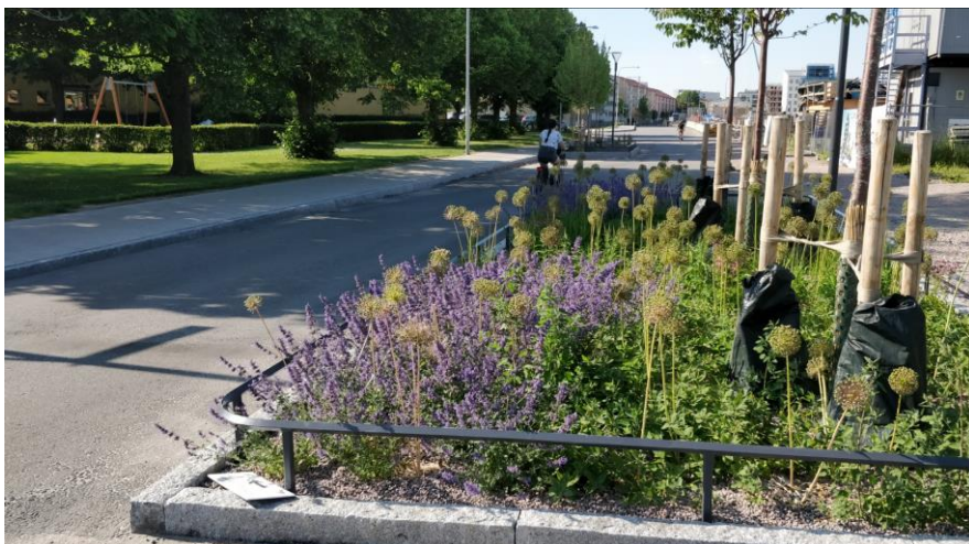
Figur 5-2. Exempel på nedsänkt växtbädd längst med väg.
