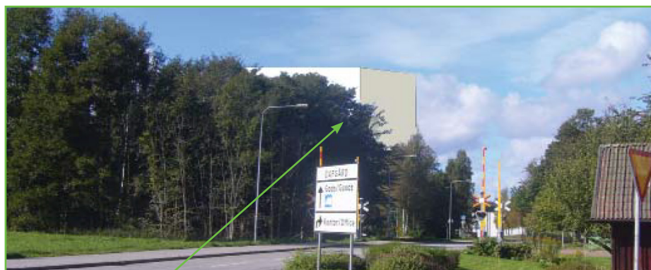
Befintligt höglager sedd från Stationsgatan
