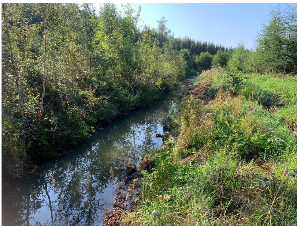
Figur 39. Läge 74. Vy från nordlig riktning den 27 augusti 2019.
