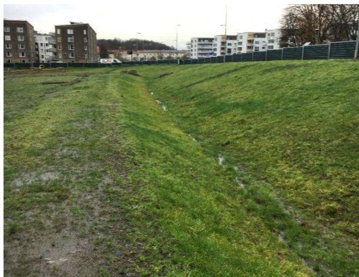
Bild Ett längre gräsklätt dike som kan motsvara ett reningsdike.
