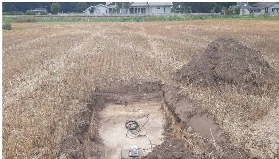
Figur 7 Mätplats i schaktgrop
