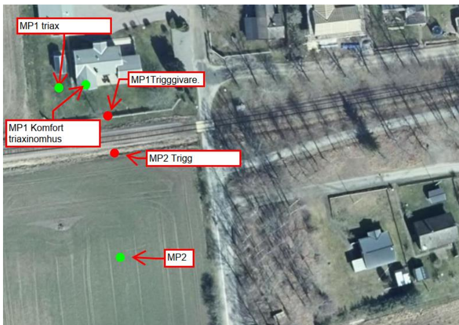
Figur 2 Röda punkter markerar referenspunkt. Grön punkt indikerar mätpunkt för triaxiell komfortmätning av vibrationer. Mätning 2022-08-26
