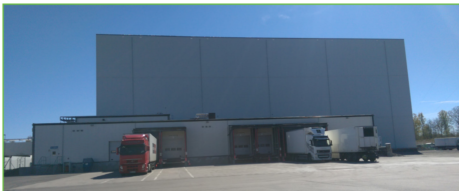
Befintligt höglager med dess utlastningsdel mot väster
