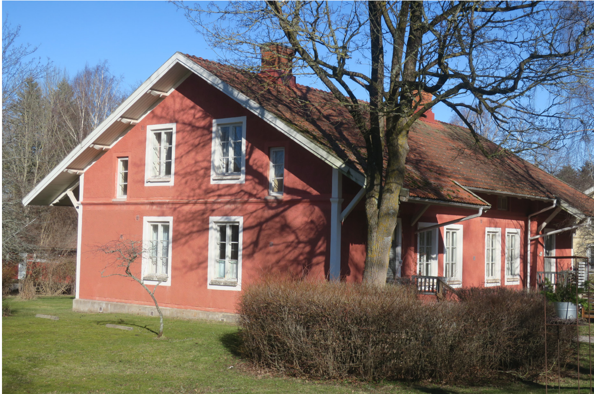
Hus nr. 65 från sydväst.
