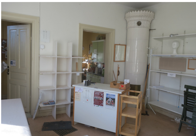
Hantverksateljé/butik i ett av rummen på bottenvåningen. Kakelugn, spegeldörrar, foder och pappspänt tak från byggnadstiden. På övervåningen används lägenheterna som rum för vandrarhemmet, även där är brädgolv, dörrar och lister från byggnadstiden.
