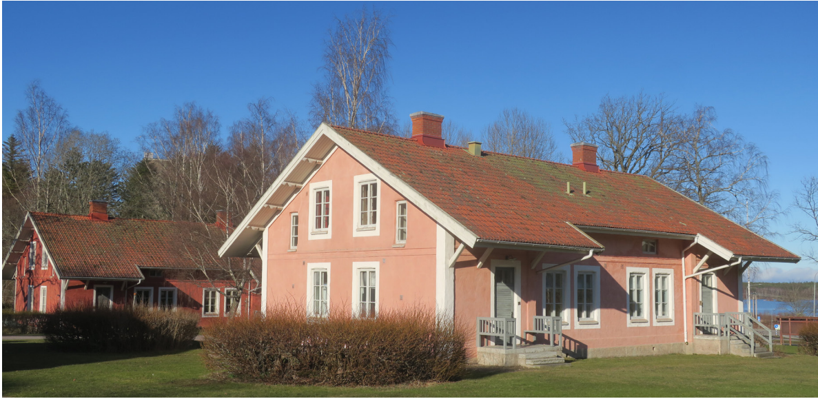
Hus nr. 69 från sydväst.
