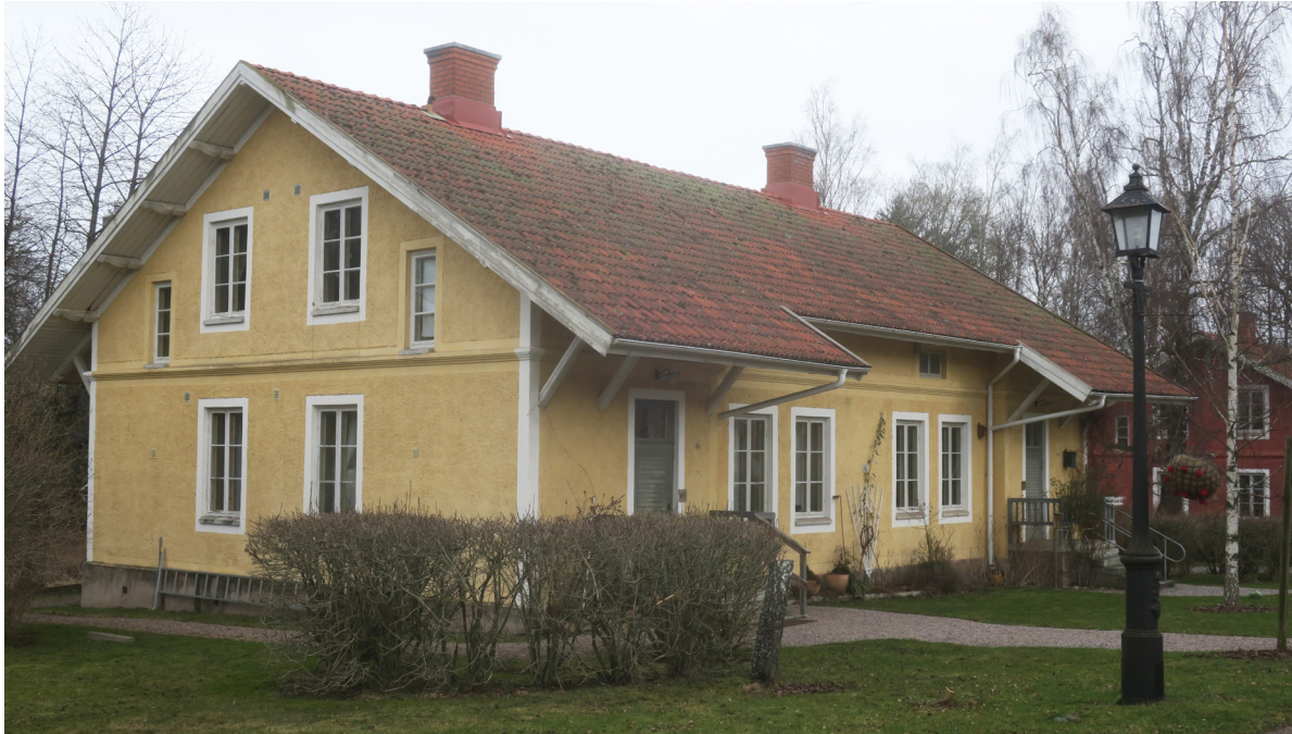
Hus nr. 67 från sydväst.
