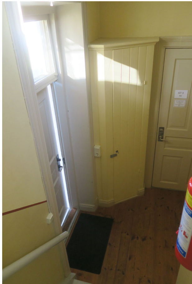
Hall med bevarad pärlspontsgarderob och rekonstruerad äldre färgsättning.
