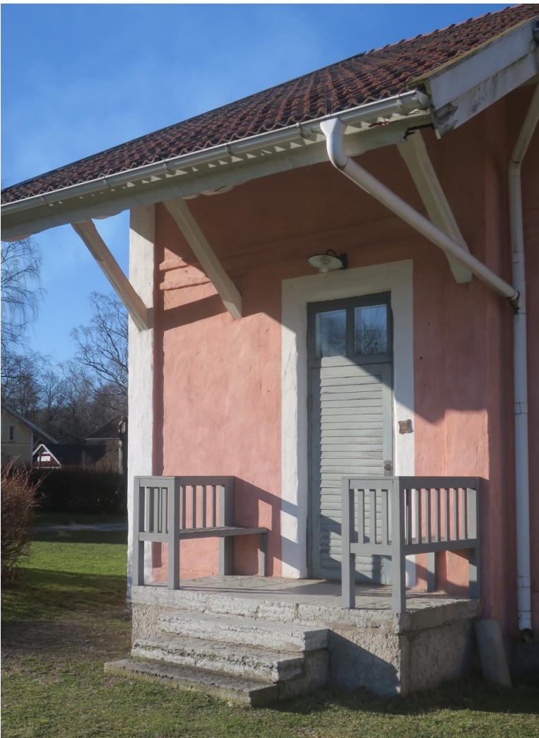
Bostadshuset uppvisar många karaktärsskapande detaljer från byggnadstiden: utspringande skärmtak på konsoler över ingångarna med sina trappor av Kinnekullekalksten och sittbänkar, ursprungliga fönsterbågar och dörrar, pärlspont på takskägg.
