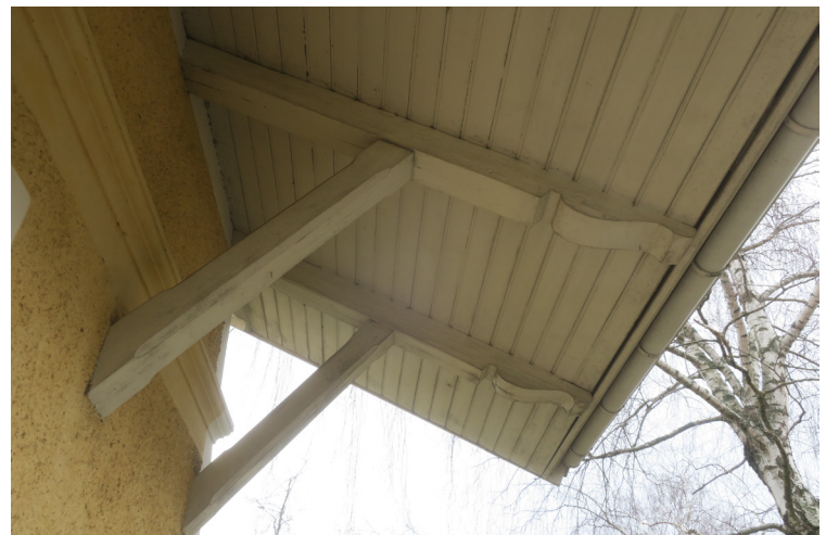
Bostadshuset uppvisar många karaktärsskapande detaljer från byggnadstiden: utspringande skärmtak på konsoler över ingångarna med sina trappor av Kinnekullekalksten och sittbänkar, ursprungliga fönsterbågar och dörrar, pärlspont på takskägg.
