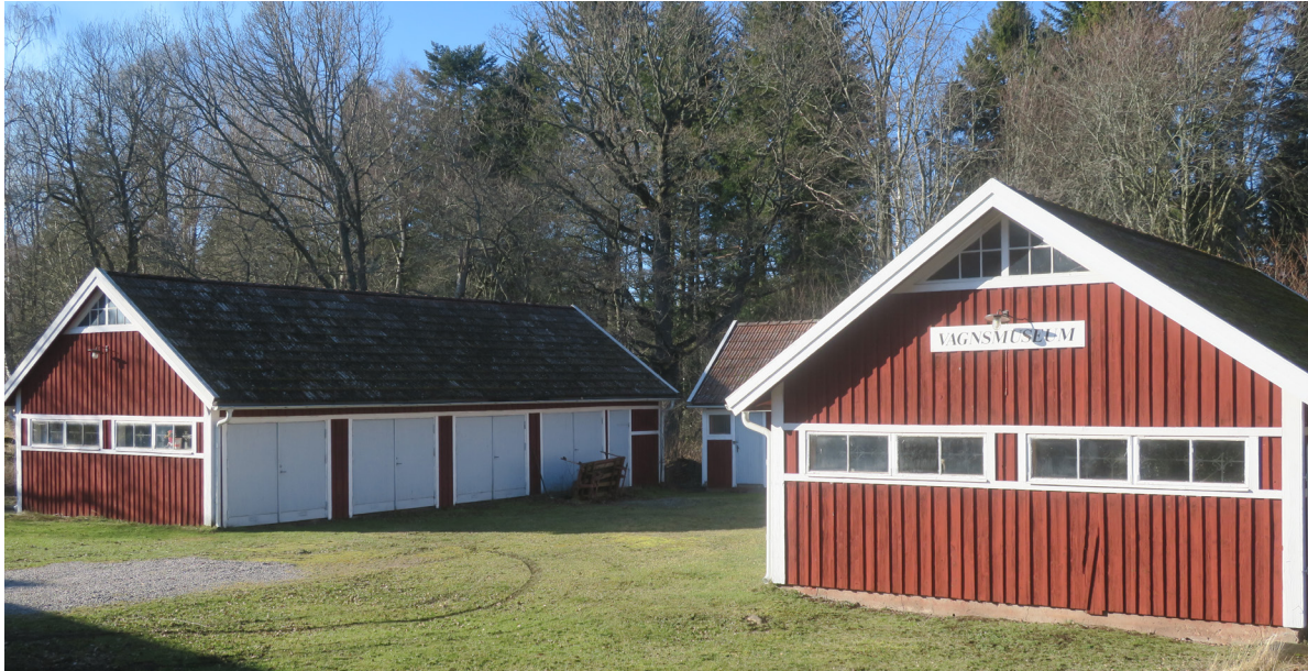
Flertalet av långorna har moderniserats med nya dörrar och fönsterbågar.
