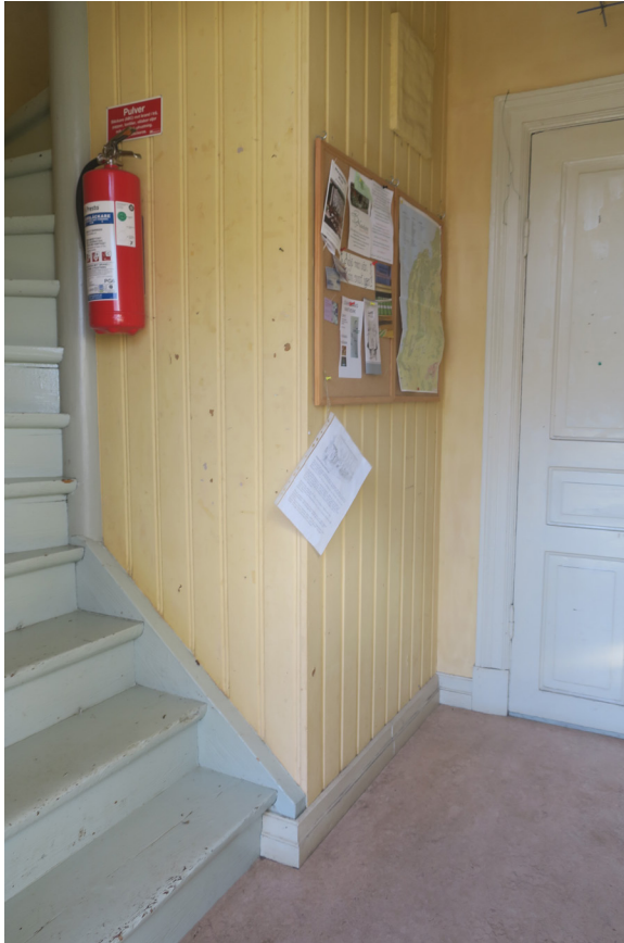
Hall/trapphus med trappa, skafferi, pärlspont, spegeldörrar och foder från byggnadstiden.
