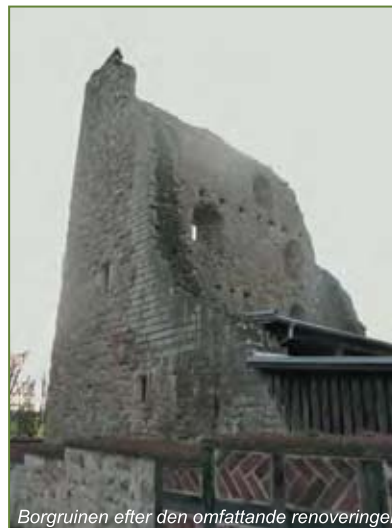
Borgruinen efter den omfattande renoveringen
