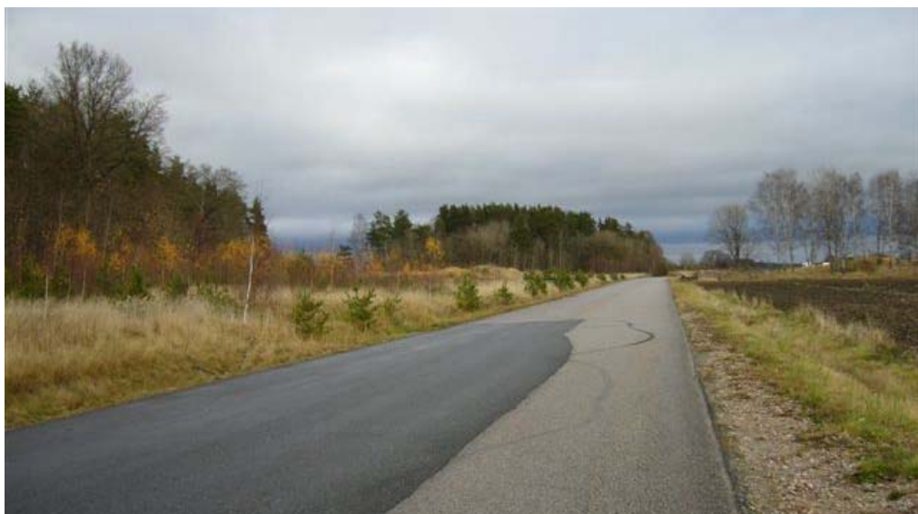
Lundängsgatan vid entrén till anläggningen – mot öster
