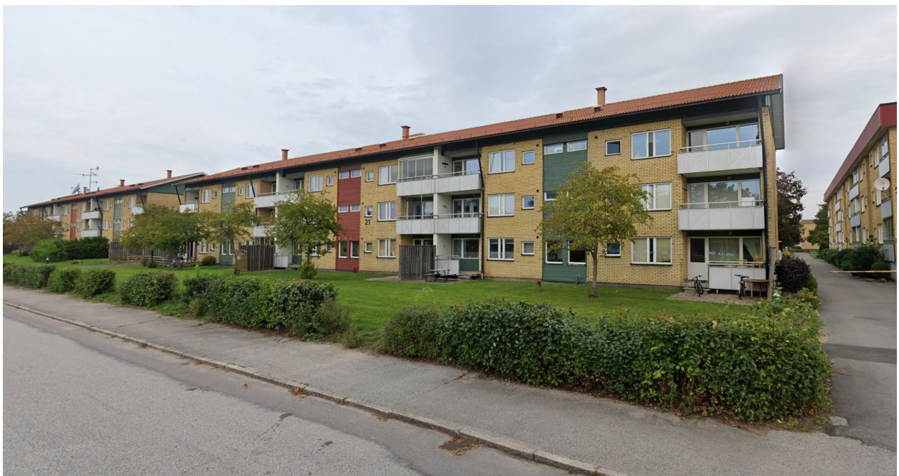
Figur 11. Ett av de 12 lamellhusen inom planområdet.
