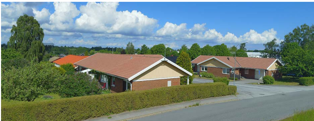
Småhusbebyggelse Smedjevägen (från Backavägen). Fasadbeklädnad av fasadtegel men övre gavelparti klätt med stående panel. Takbeläggning rött, taktegel eller möjligen betongtakpannor.
