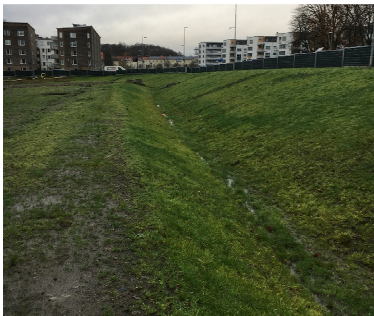
Bild. Ett längre gräsklätt dike som kan motsvara ett reningsdike.
