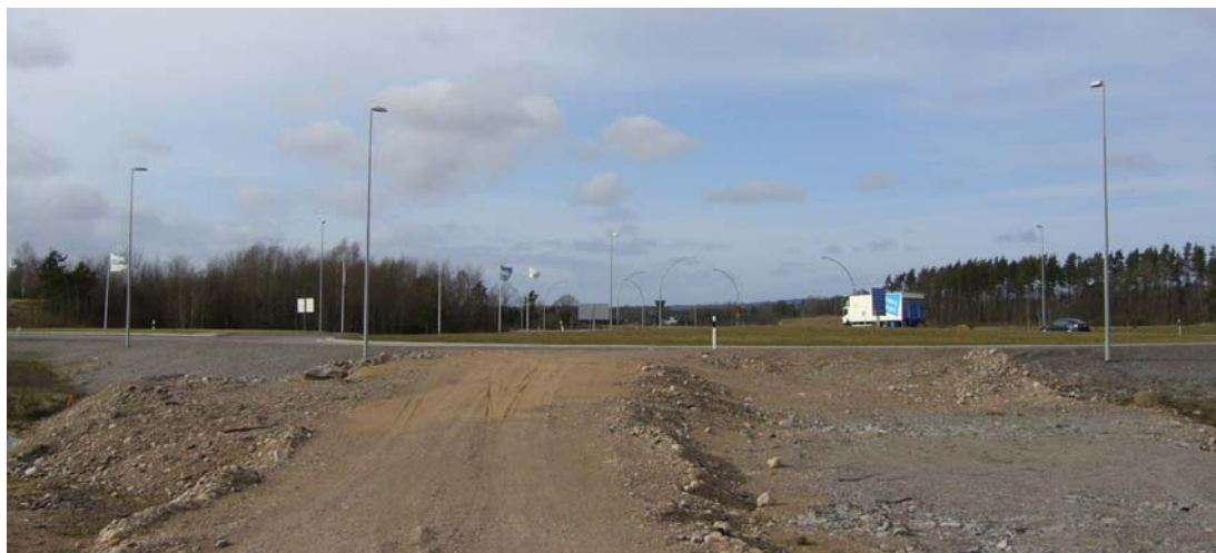
Rondell i korsningen nuvarande E20 – Rv44 – mot väster
