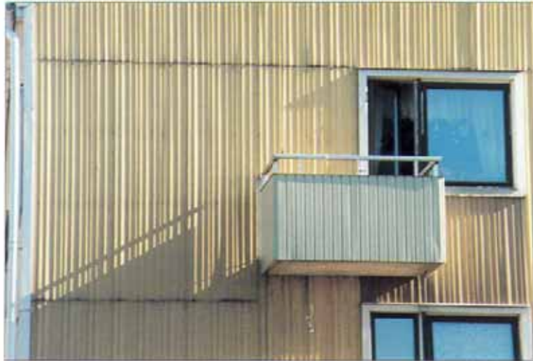
Ljus och skuggor kan ge oanade effekter som aldrig syns på bygglovhandlingar. På den här bilden har den tidigare slätputsade fasaden försetts med plåt. Balkongfronten är också utbytt till en annan plåttyp.
