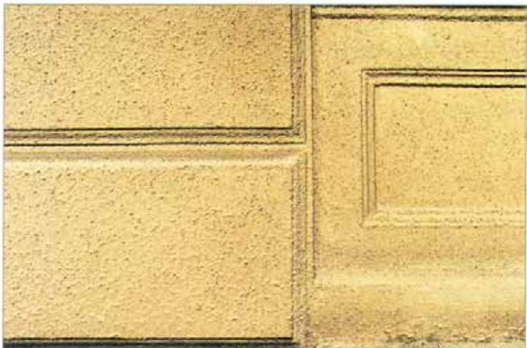
Det putsade listverket med sina distinkta, skarpa linjer som är tänkt att fånga ljus och skugga tappar sitt precisa uttryck när fasaden spritputsas.
