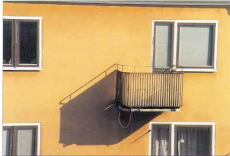
Femtioalets arkitektur karakteriseras av puts- och tegelfasader. Bilden visar en slätputsad fasad med ljusa fönsteromfattningar. Balkongfronten lämnar bottenplattan fri.
