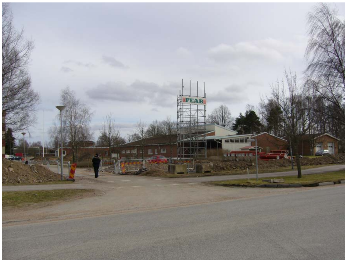
Infarten till Helenagården från Järnvägsgatan. Markarbeten för omläggning av ledningar pågår.
