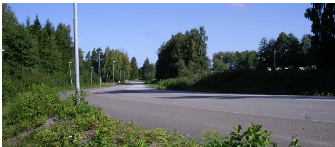
Nuvarande Vänernvägen i blivande anslutningspunkt för den nya infarten
