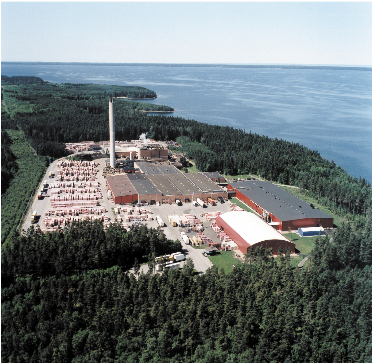
Figur 16. Foto över industriområdet inom fastigheten Hönsäter 5:12.
