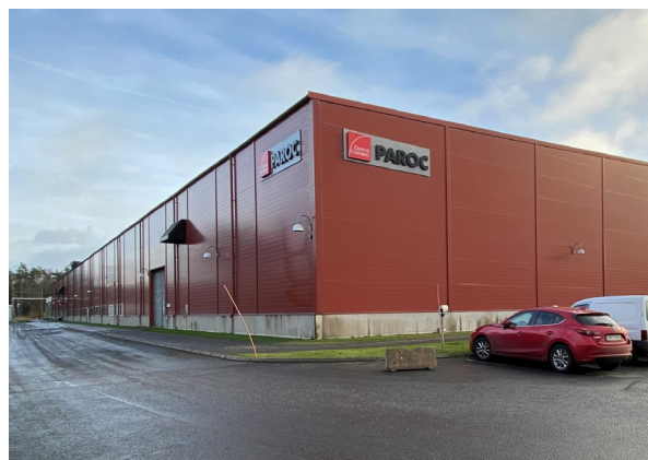
Figur 35. Bilden visar en av de nyare byggnaderna i området. Färgen skulle förslagsvis kunna användas som accentfärg på utvalda byggnadsdelar på tillkommande bebyggelse.
